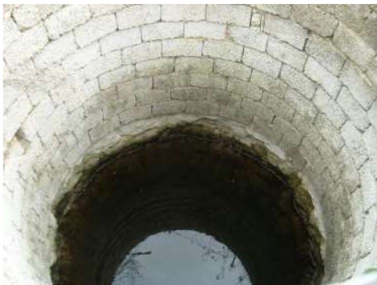
Pozzo scavato in località Su Sciu – falda a -3.0 m dal p.c.
